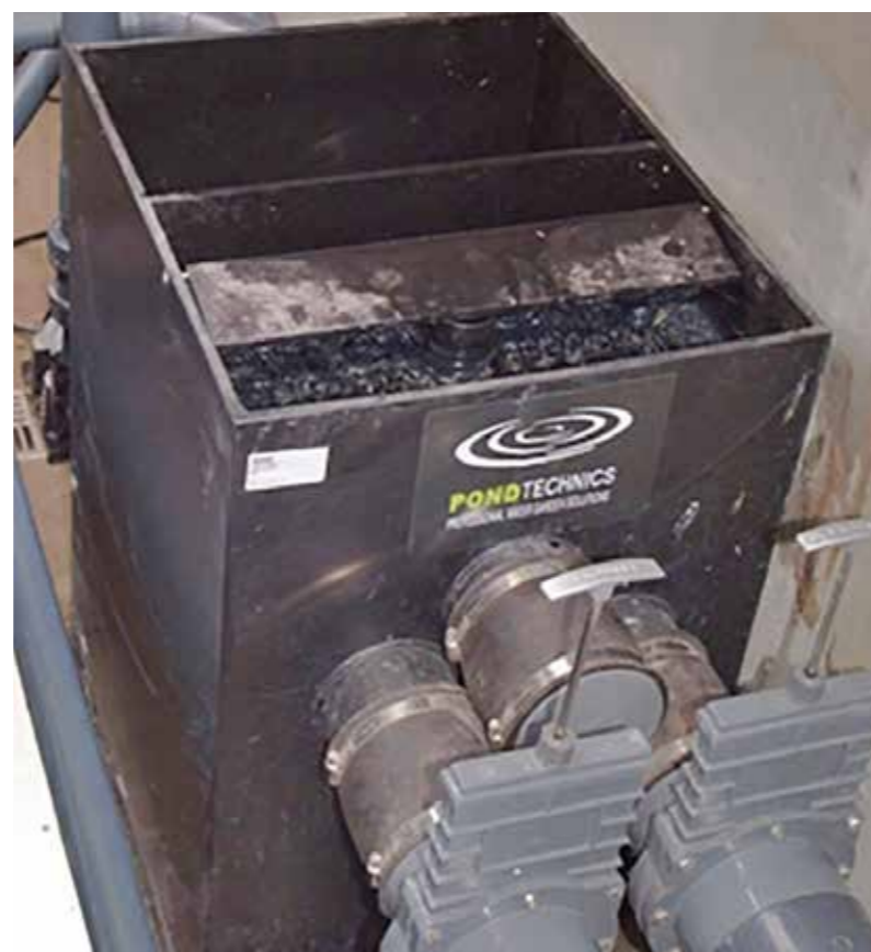
Pond Sieve in combinatie met Pond Technics Satellietkimmer, Pond Clean UV-c unit en Messner Eco-Tec 2 pompen
