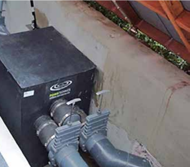
Pond Sieve in combinatie met Pond Technics Satellietskimmer, Pond Clean UV-c unit en Messner Eco-Tec 2 pompen
