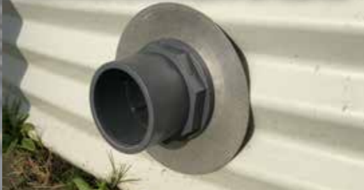
Raccordement à la paroi du réservoir
